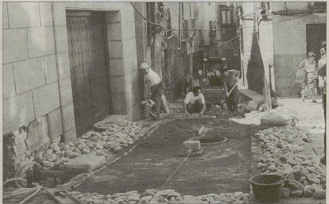
Estado actual de las obras. / SANDRA GÓMEZ
