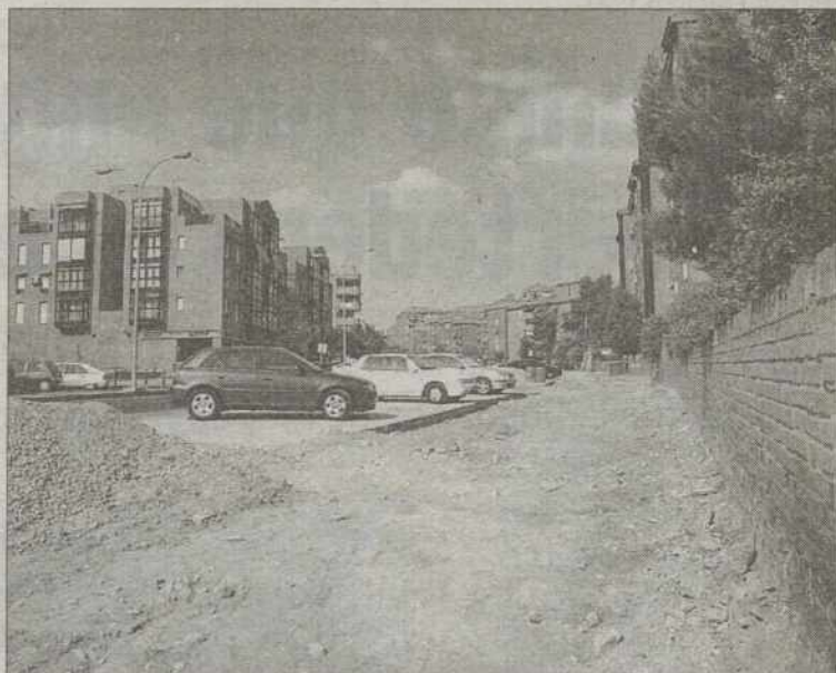
Foto de archivo de las obras que se están realizando en Buenavista. / VALDIVIELSO
