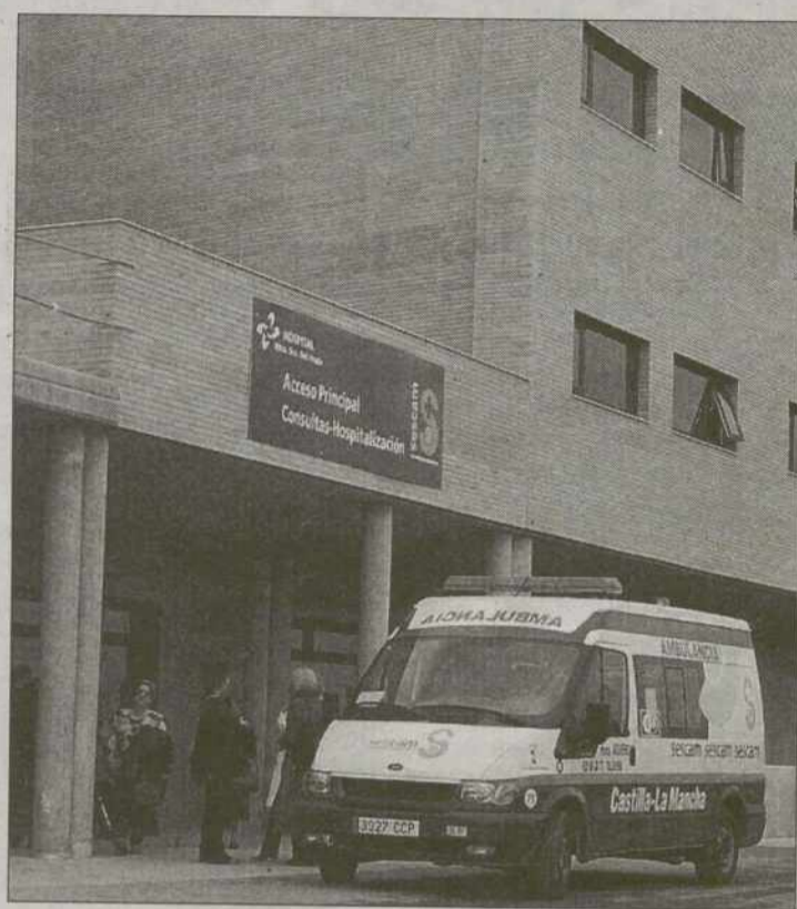
Las obras del Hospital han dejado inutilizados varios aparatos de aire. / M. R.
