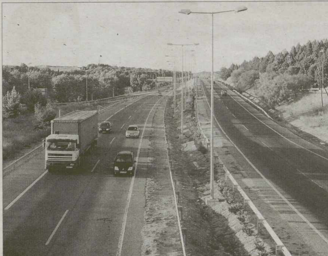
El tramo tendrá una primera entrada en la Radial 5 de Madrid y ofertará una alternativa a la 401. / YOLANDA LANCHAS
