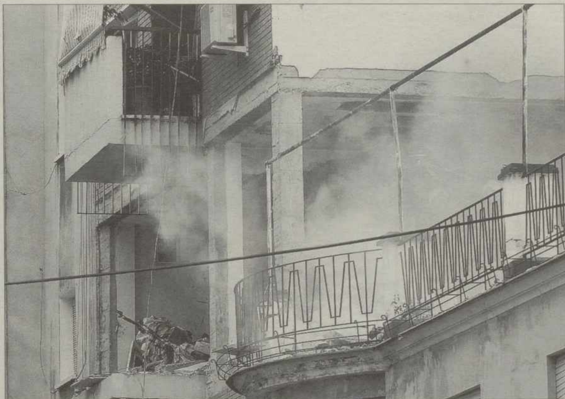
Estado en el que quedó la vivienda que en la que se produjo la explosión ayer en Málaga. / EFE
