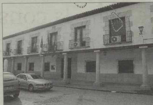
El Ayuntamiento también será objeto de obras.
