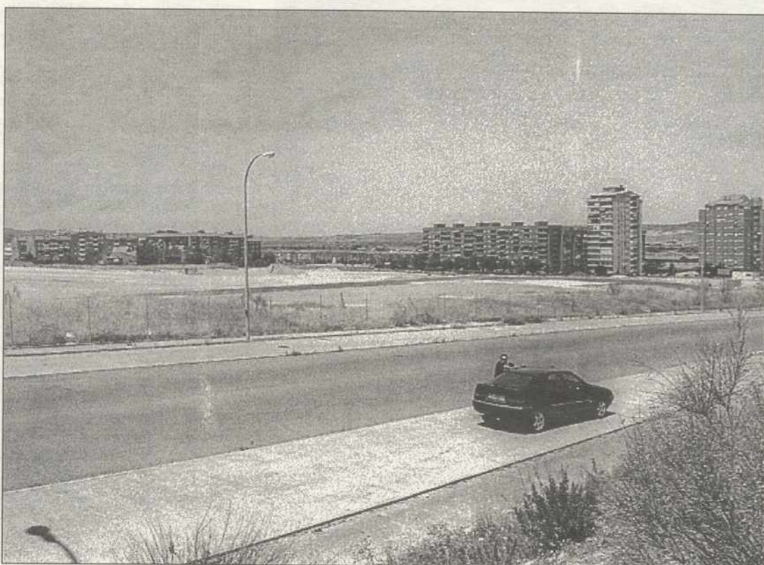
El Ayuntamiento reclama a la Junta que aborde el desarrollo urbanístico del Polígono residencial Y. Lancha
