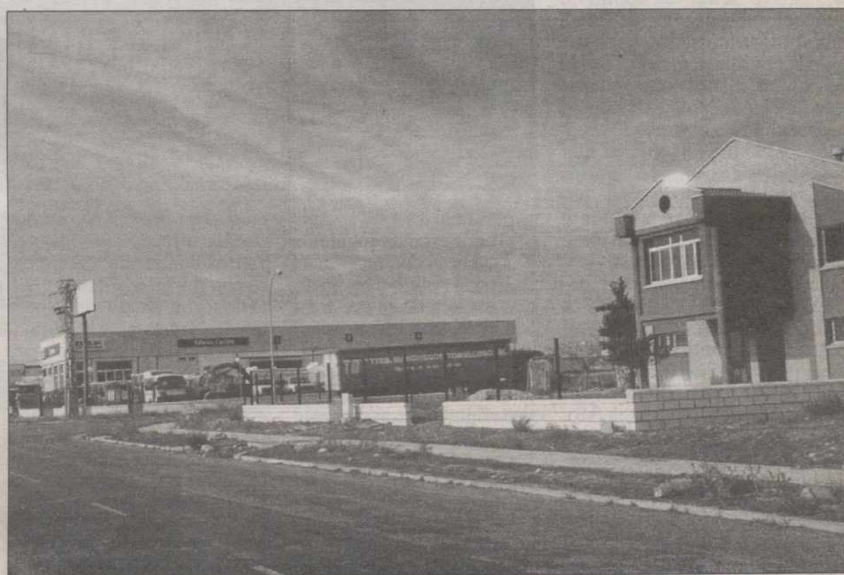
FEPEMTA denuncia que instalarse en Torrehierro sigue costando demasiado en muchos casos.
