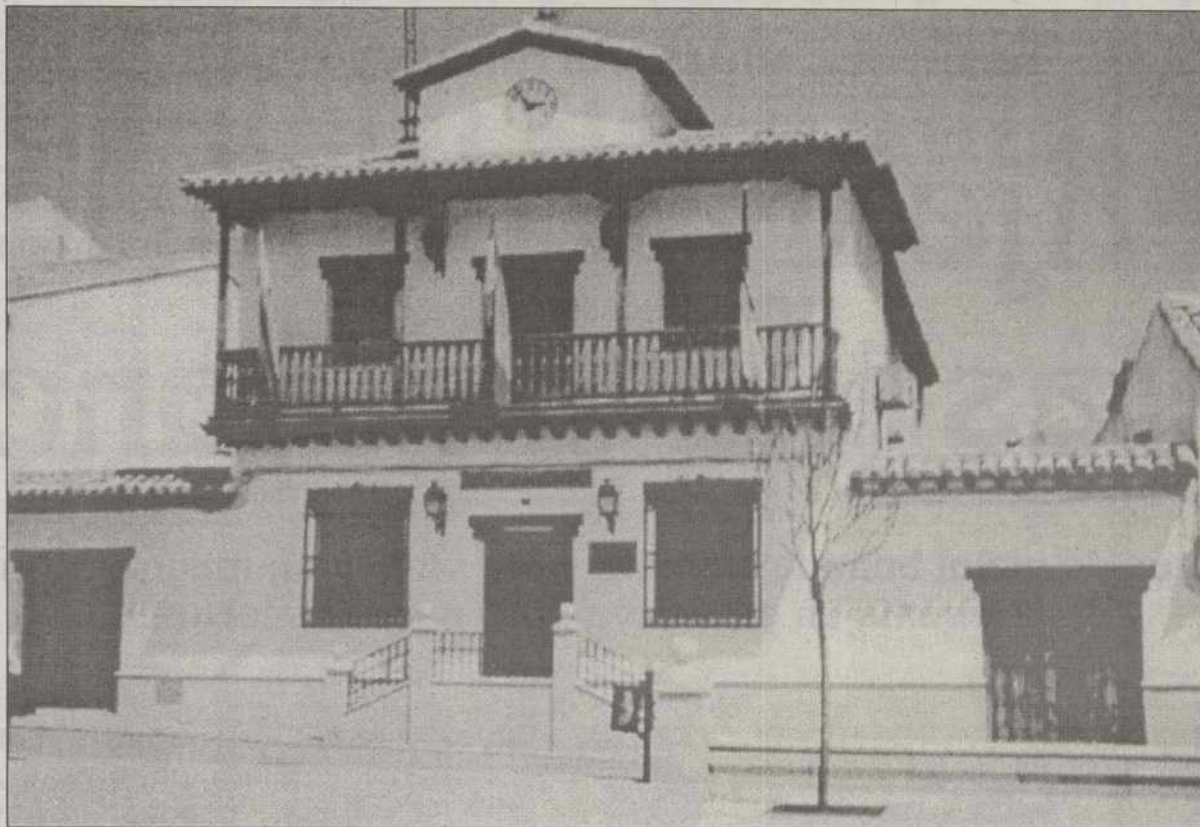
El Ayuntamiento de Villaseca ha invertido veinte millones en la rehabilitación del antiguo granero.
