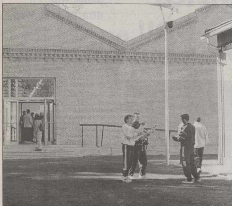
En 9 meses se han rehabilitado 12.000 metros cuadrados.
