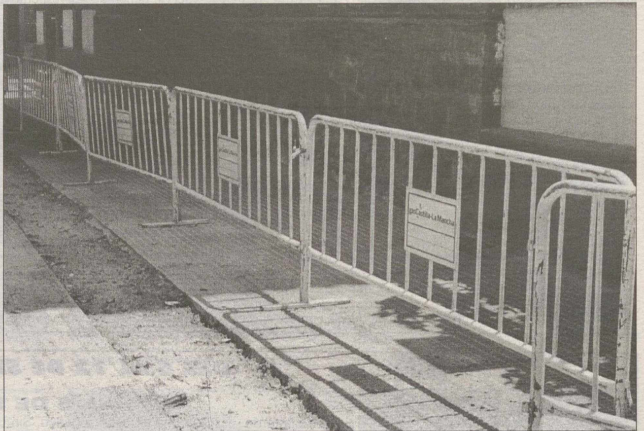
Las obras para las conducciones del gas natural se están convirtiendo en una imagen habitual.
