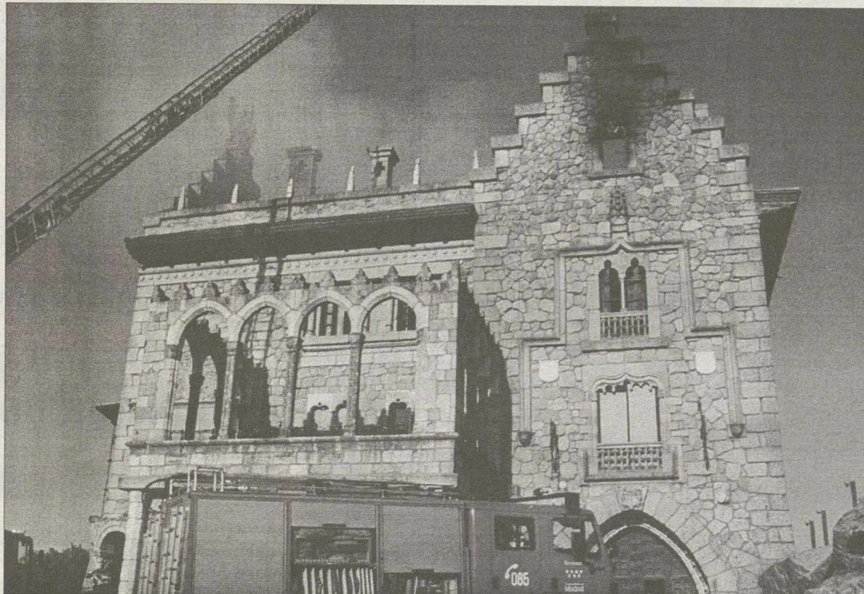
El incendio fue provocado.
