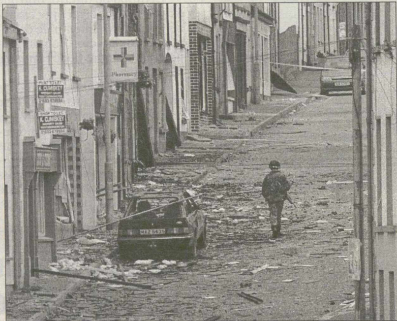
Estado en que quedó la calle donde explotó el coche bomba.
