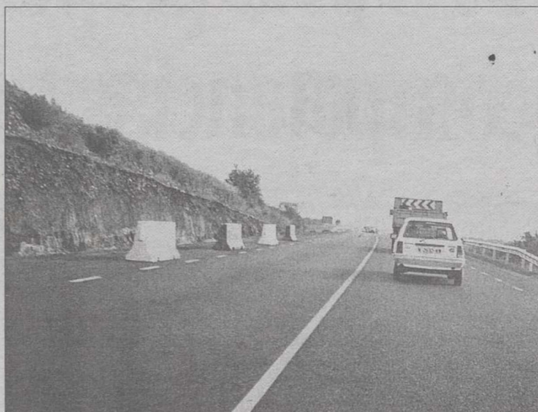
Los conductores se encontrarán con 19 tramos en obras en la región.
