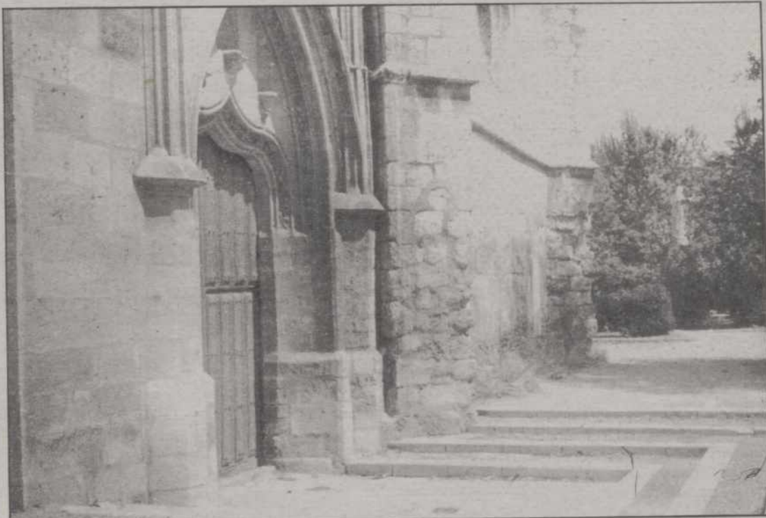
También el convento de San Pablo fue reclamado para establecer la cárcel de Palencia
