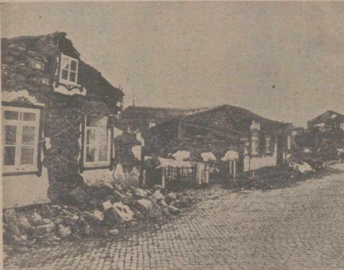
TERCEIRA (Islas Azores).—Casas destruidas en la localidad de San Sebastiao de la isla Terceira, a consecuencia del terremoto que el pasado domingo sacudió a las Azores, considerado como el peor de los conocidos hasta ahora. Por el momento hay que lamentar 49 muertos y varios centenares de heridos. (Telefoto Efe-Upi).
