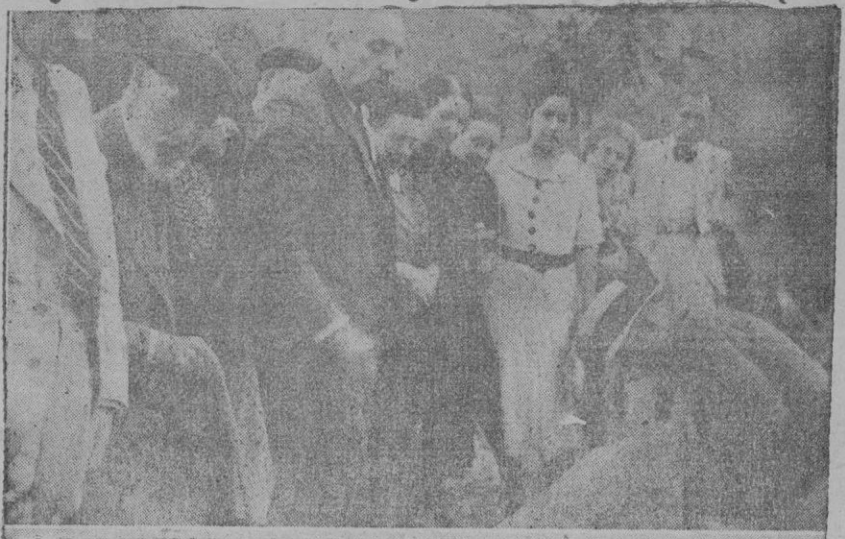
El ingeniero Sr. Zaforteza explicando a una comisión de vecinos de Son Rapiña y La Vilita las obras para el abastecimiento de aguas a dichas caserías
