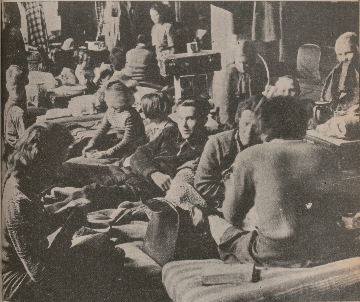
En un centro de refugiados instalado en el Berlín occidental
