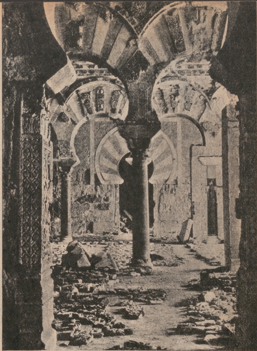
Medina Az-Zahara (Córdoba). Estructura del gran salón, obtenida por el armado de los elementos hallados en la excavación
