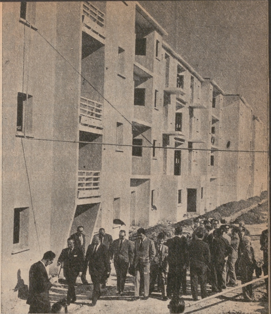
Uno de los bloques de viviendas que la Obra Social de la Falange construye en la zona Sur de Córdoba
