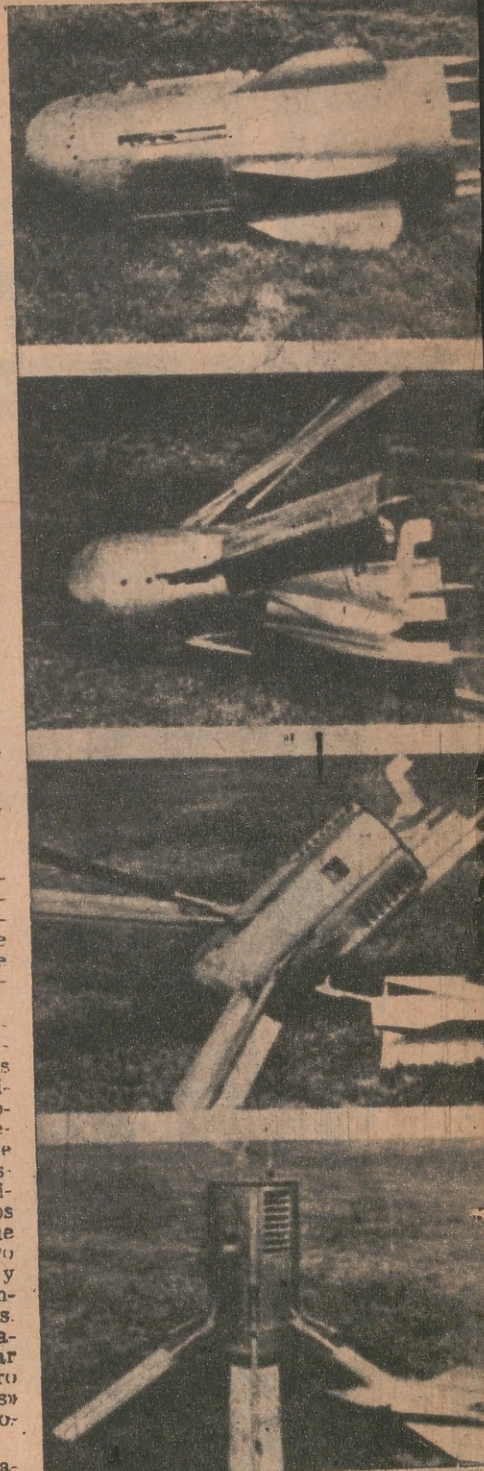
Así funciona el «Saltamontes». Tras de su llegada a tierra y liberación del paracaídas, el «saltamontes» se endereza sobre sus aletas extensibles y comienza inmediatamente a transmitir por radio las observaciones meteorológicas registradas por sus instrumentos.
