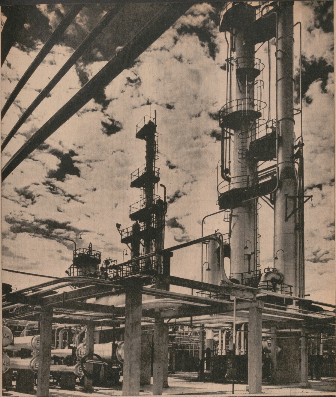
Dentro de unos años, las instalaciones fabriles españolas serán de las más modernas de Europa. He aquí una vista parcial del campo de Escombreras
