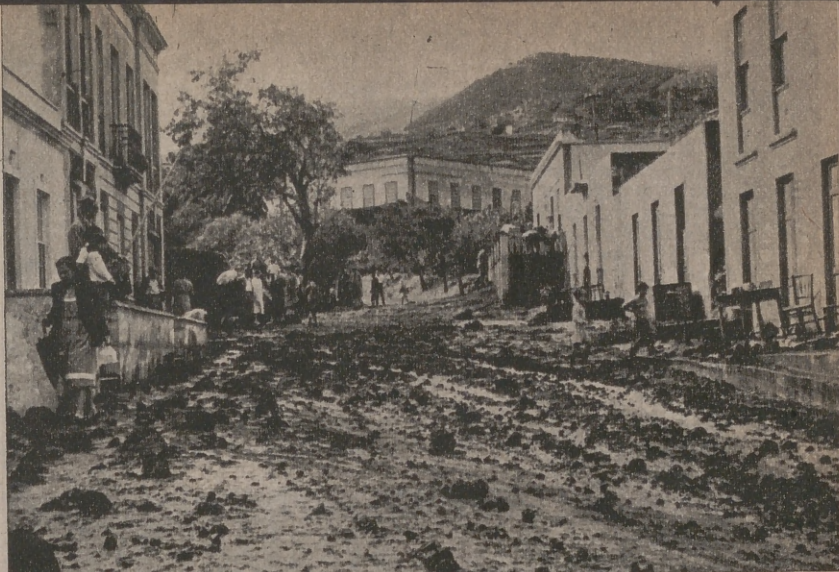
Parte del caserío de San Antonio sufre los efectos de un desbordamiento de las aguas del barranco de Amargavinos, el año pasado (febrero de 1956). Casi todas estas viviendas desaparecieron el 17 de enero de este año
