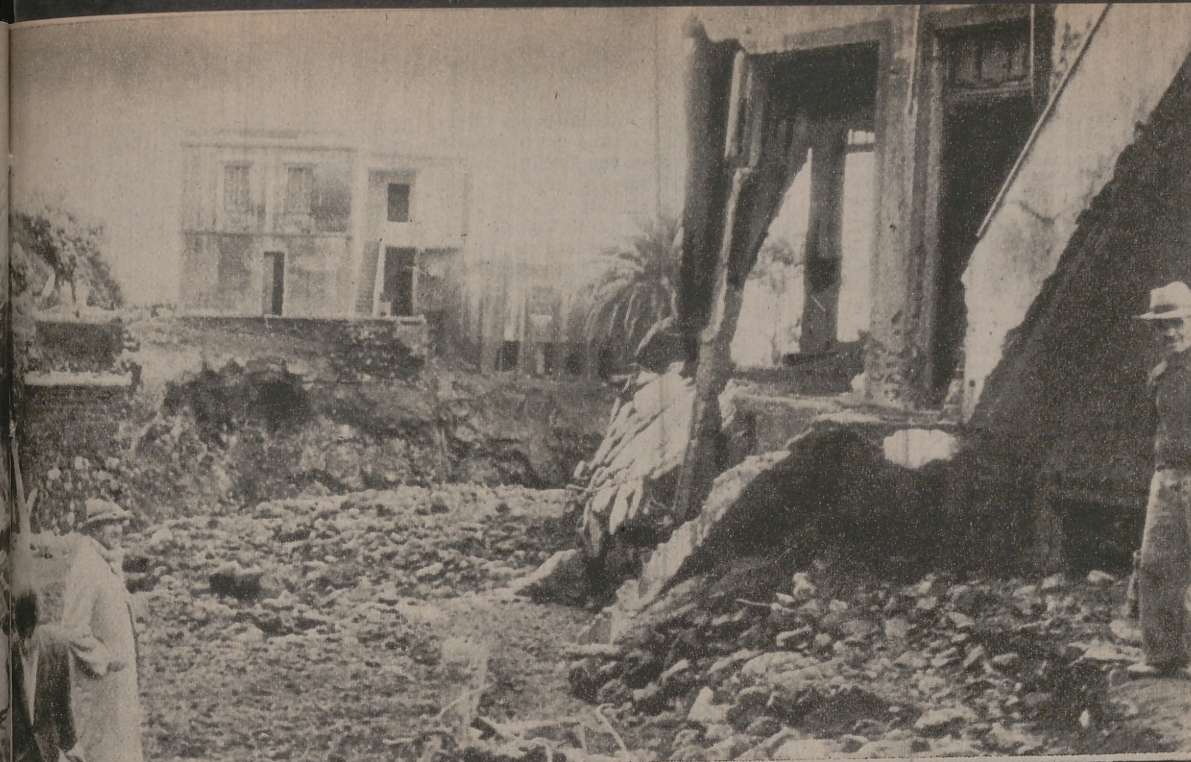
Parece que la tierra ha temblado en los Llanitos. La fuerza de las aguas no ha perdonado tapia ni pared de casa
