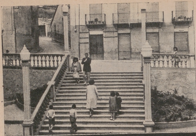
Importantes obras municipales están transformando las calles y plazas de Agreda con moderno sentido urbanístico
