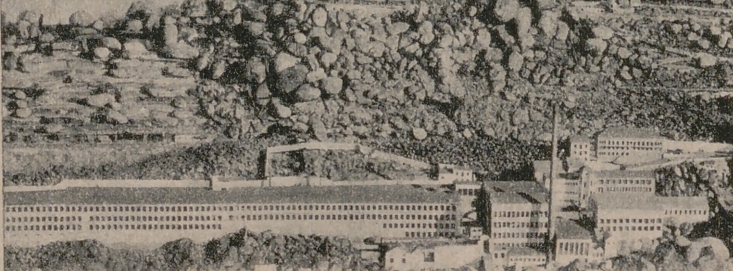
La fábrica, vista en su totalidad
