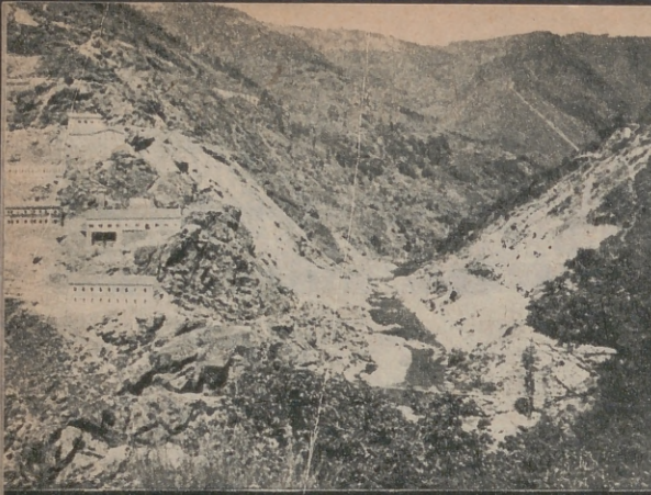
panorámica del emplazamiento de la presa al nazo de las excavaciones (25 de mayo de 1946)
