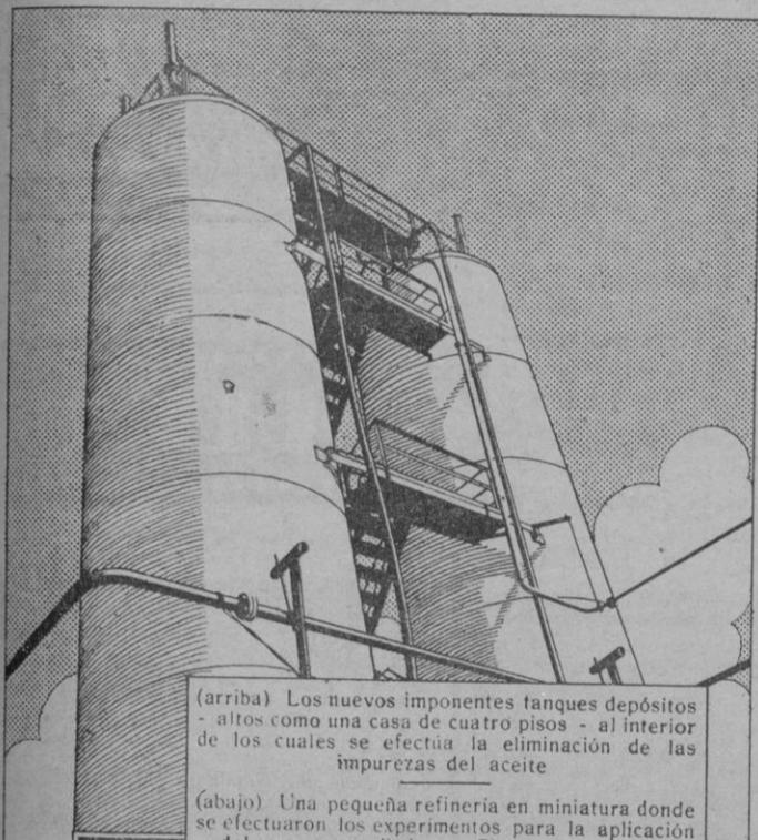
(arriba) Los nuevos imponentes tanques depósitos - altos como una casa de cuatro pisos - al interior de los cuales se efectúa la eliminación de las impurezas del aceite
