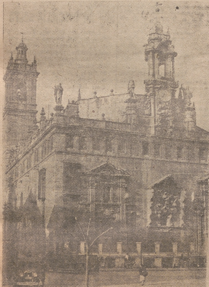
Fotografía de la parroquia de los Santos Juanes en la que se instala el altar de San Vicente de la plaza del Mercado
