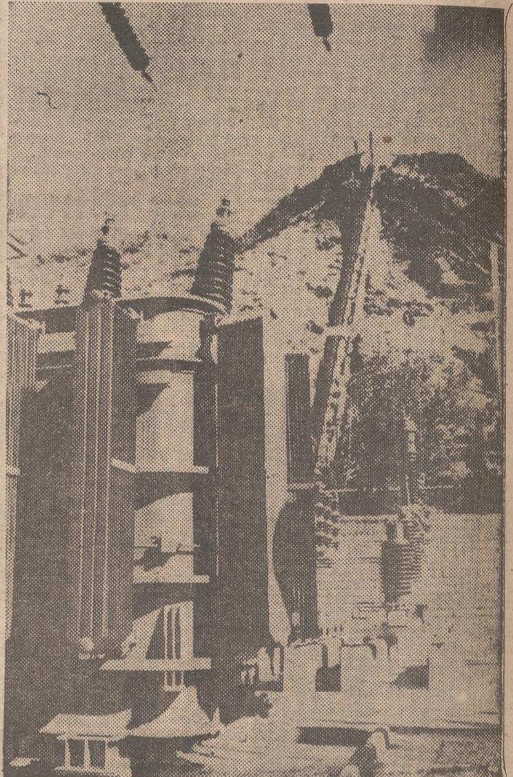
Instalaciones de la central eléctrica de Llesp y tubería de entrada, inauguradas por Su Excelencia el Jefe del Estado recientemente. Tiene una potencia en turbinas de 17.560 CV, y en alternadores de 12.400 KW. a 15.500 KW.
