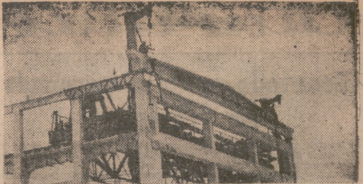
Invitadas por la Empresa Constructora SICOP, S. A., destacadas personalidades militares y civiles del ramo de la construcción visitaron las obras de ampliación de la Fábrica de Cementos de Buñol, presenciando las operaciones de montaje de las vigas de hormigón pretensado, que constituyen la estructura fundamental de la cubierta de la nave de materias primas. Esta es la primera vez que en España se emplea el hormigón pretensado para grandes luces, mostrando su ala de magnífico de realización, lograda por técnicos, empleados, acero y cementos españoles
