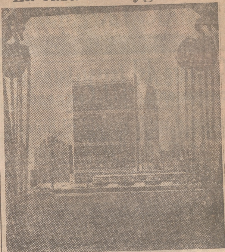
El edificio del secretariado de la O. N. U. en Manhattan. Tiene treinta y nueve pisos, y está situado a orillas del East River
