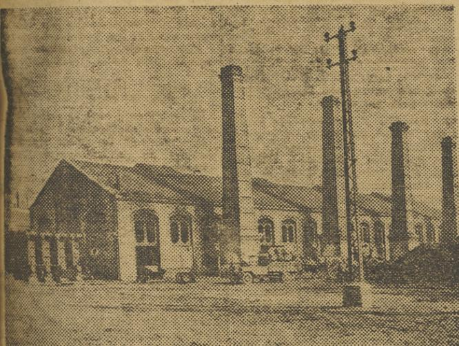
La primera instalación de fábrica de gas Lebón, en Valencia, con hornos horizontales y carga manual
