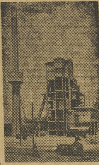
Las actuales y modernas instalaciones de la fábrica de gas, con hornos verticales y carga mecánica
