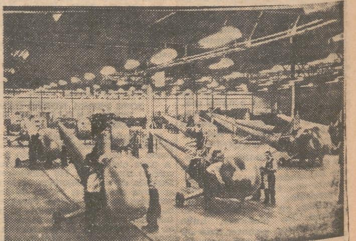
Por las cadenas de montaje de una fábrica norteamericana de aviones pasan helicópteros en curso de fabricación
