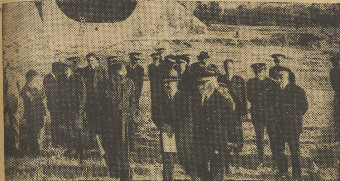
El Caudillo, en su visita a las obras de los riegos del bajo Guadalquivir.—(F. Contreras)
