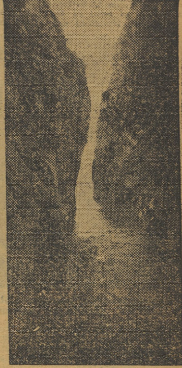
Vista del río Girona en el emplazamiento de la presa antes de comenzar las obras
