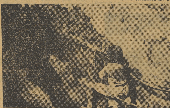
Lanzamiento del mortero de cemento a presión «Guinta»
