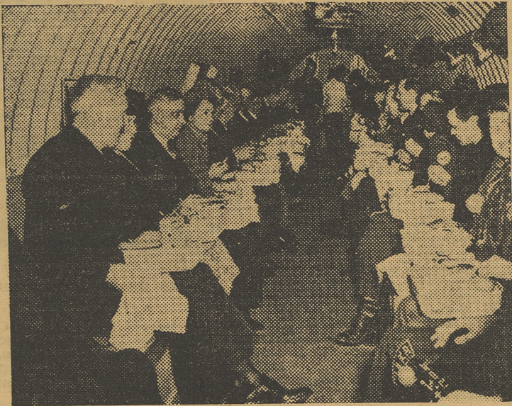
Este refugio antiáereo, construido por la Firestone Rubber Co. de Akron (Ohio), es una estructura flexible, formada con fuertes planchas onduladas, que constituyen un cilindro hermético al gas y al agua. Tiene capacidad para cincuenta personas
