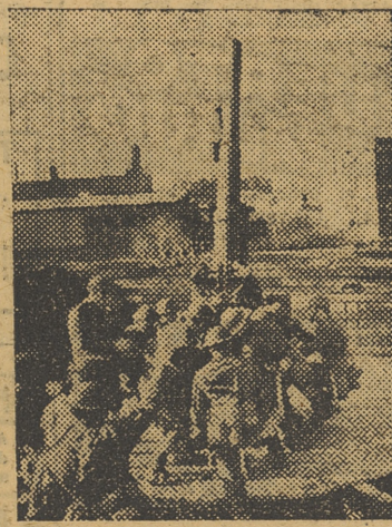
Un cañón antiaéreo, emplazado en uno de los barrios de Nueva York, en previsión de posibles ataques aéreos
