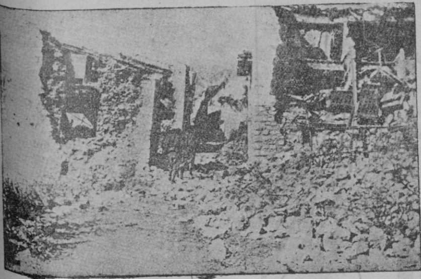
Casas derruidas por el último terremoto en las cercanías de Sulmona (Italia)
