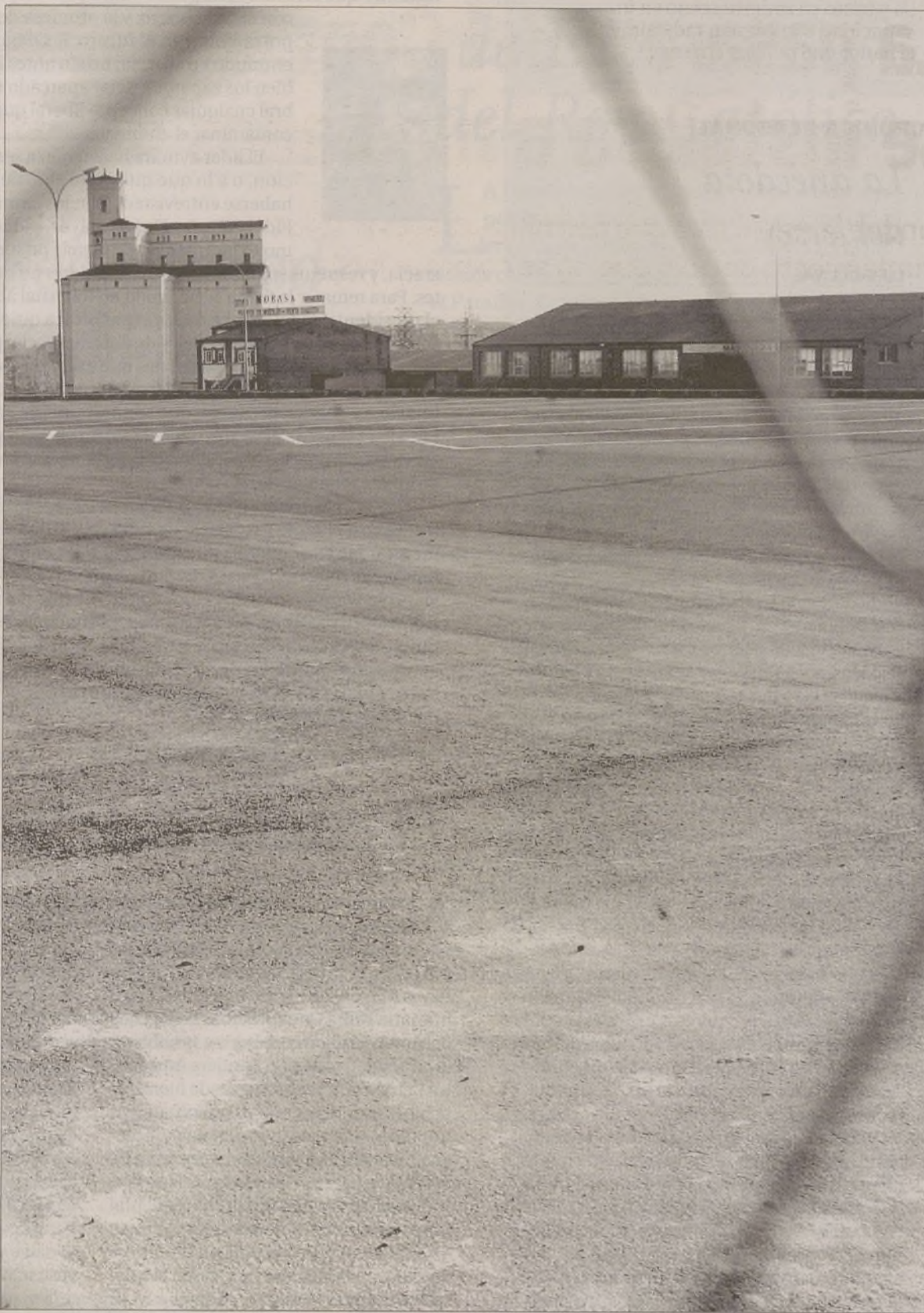
Imagen del aparcamiento de vehículos pesados del polígono industrial de Las Hervencias. /ANTONIO BARTOLOMÉ
