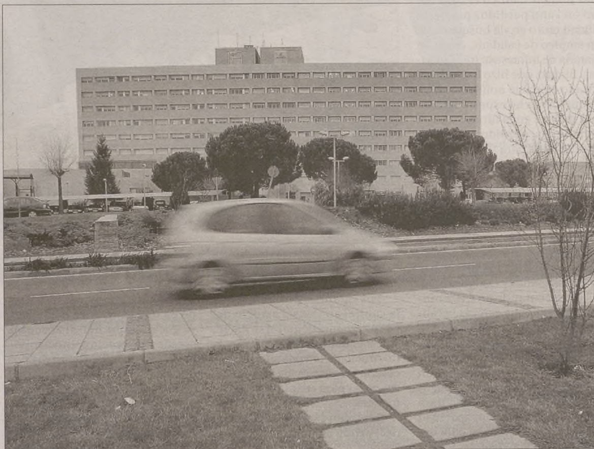
Lugar donde se colocará la pasarela peatonal del Complejo Hospitalario. / DAVID CASTRO
