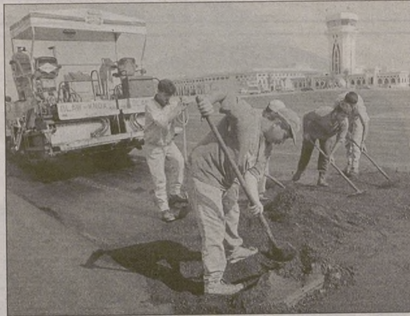
Construcción de una carretera al aeropuerto de Gaza, todavía cerrado. EFE
