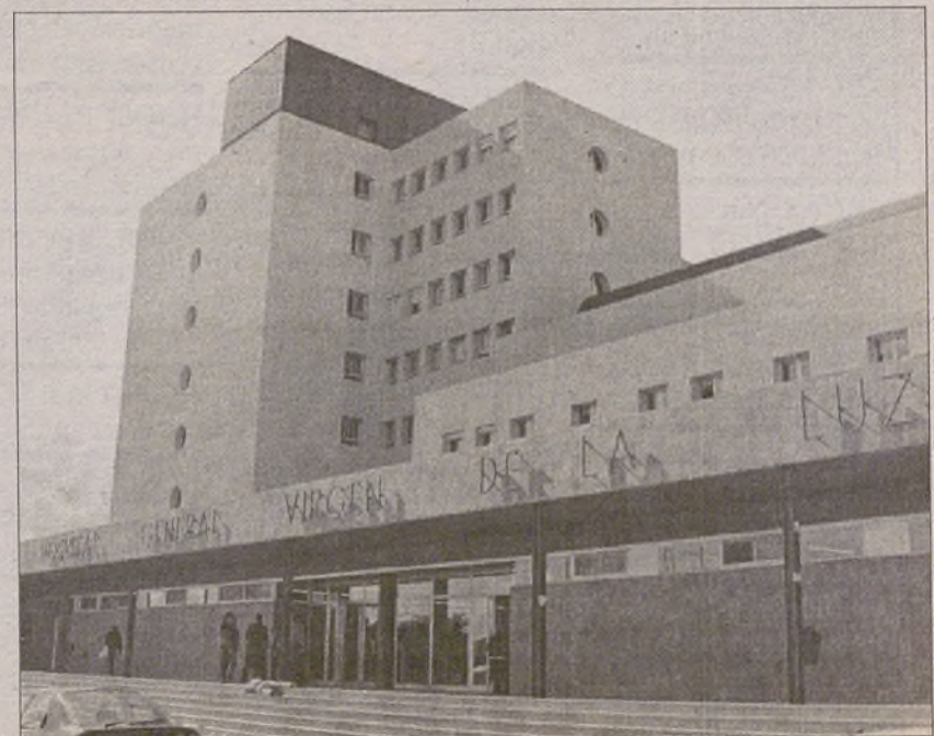
En los hospitales la esterilización debe de estar cerca del resto de salas.
