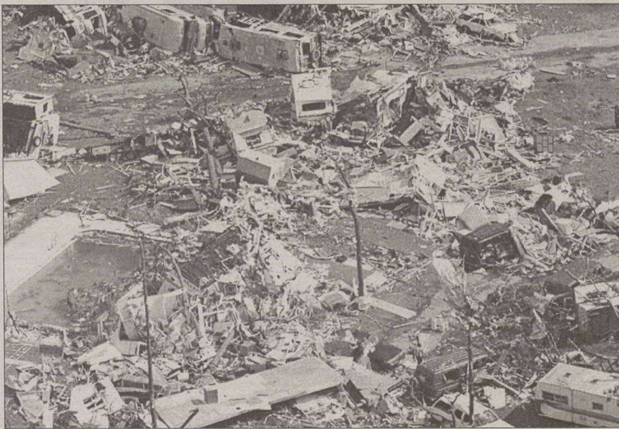
La imagen muestra las consecuencias destructivas de los tornados
