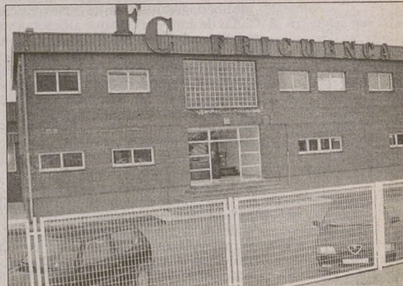
Matadero de Fricuencia, S.A., ubicado en Villar de Olalla.
