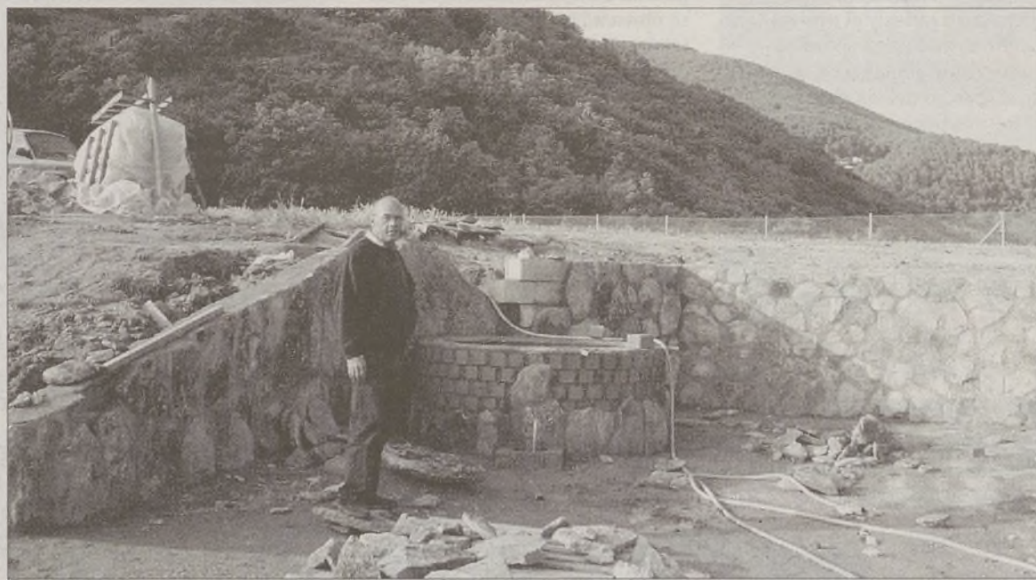
El primer teniente de alcalde del Consistorio hoyanco muestra las obras del área recreativa de Los Molinos. / MORCUENDE
