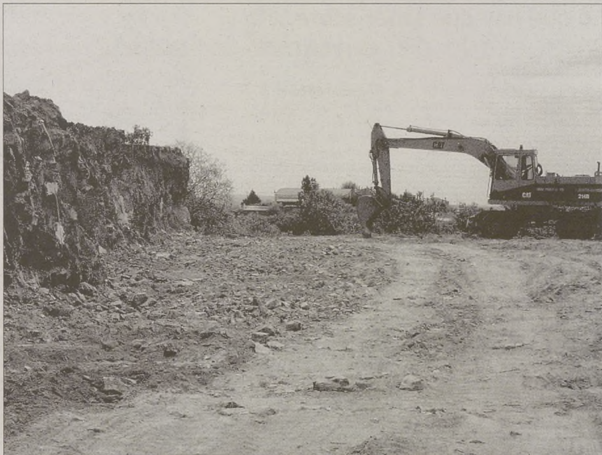
Una máquina trabaja en los desmontes del terreno donde se levantarán las viviendas sociales. / GARCÍA
