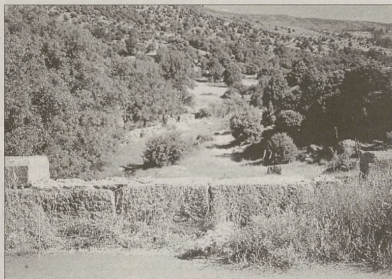
Vista del perfil del puente sin algunas piedras.
