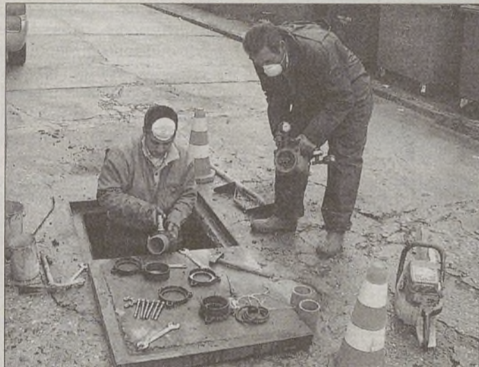
Operarios de Aquagest proceden a la reparación de una avería. / LACABA
