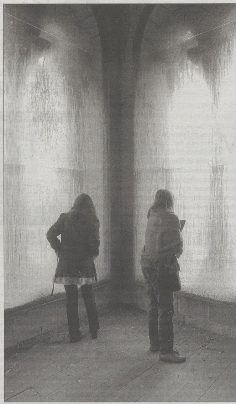
Aspecto del interior la torre de la basílica por los excrementos de paloma. / D. CASTRO
