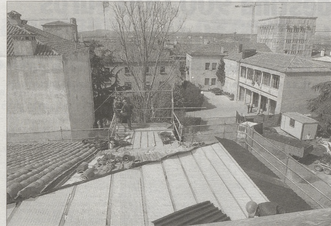
En primer plano, obras en la cubierta del Episcopio. / ENRIQUE
