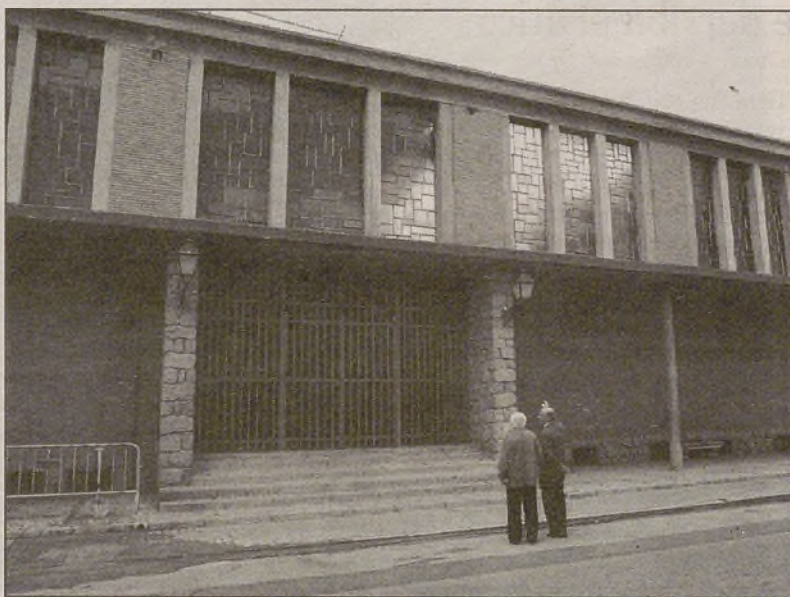
Exterior de la iglesia, horas después del derrumbamiento
