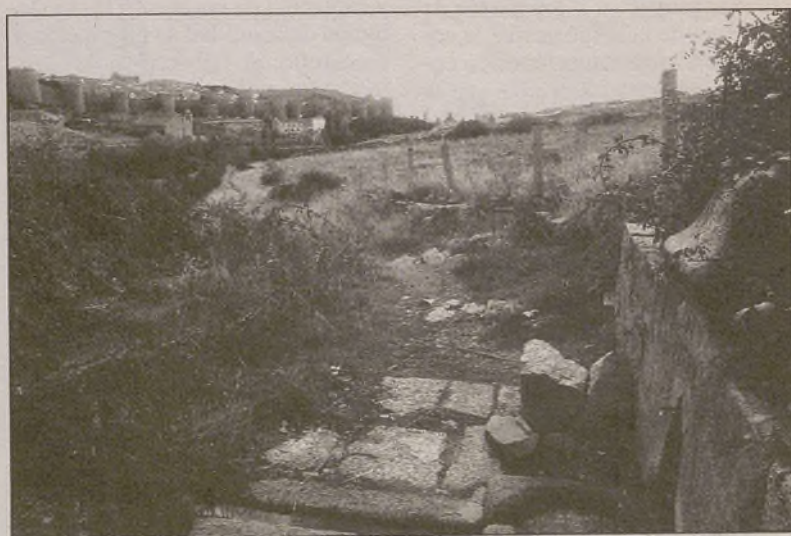
Estado actual de la Fuente de la Canaleja / LUMBRERAS
