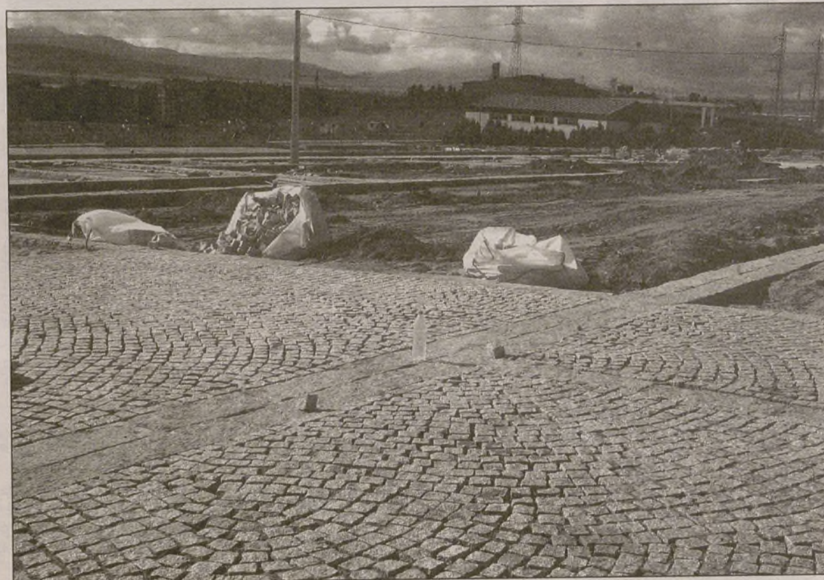
Obras de urbanización del Campus Politécnico de Ávila / LUMBRERAS
