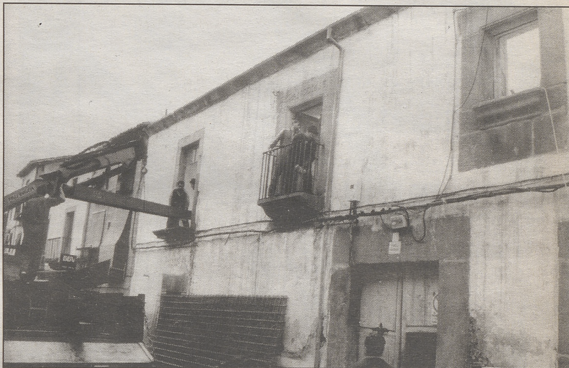
Fachada de la antigua cárcel, hoy proyecto de biblioteca.
