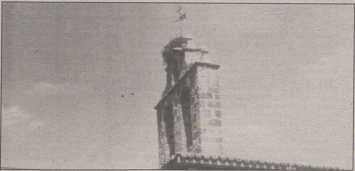
Detalle de la Torre del convento
