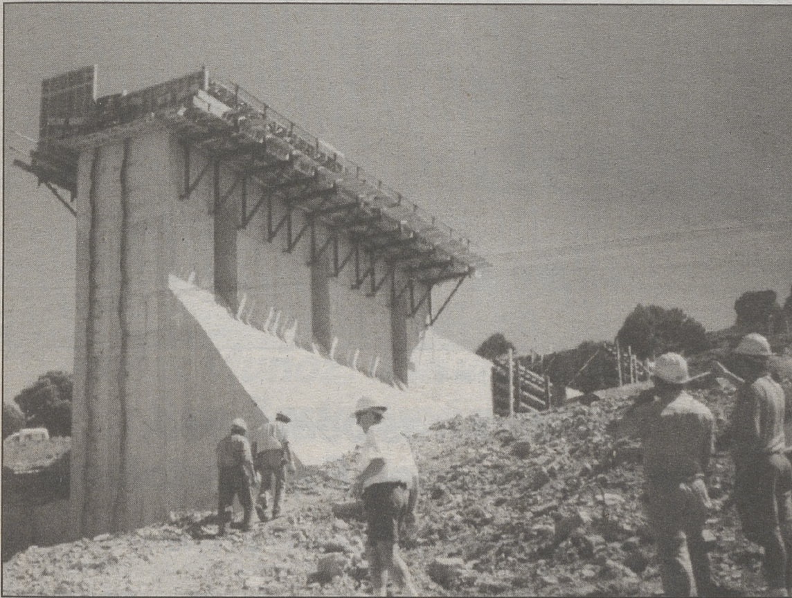
Vista de la presa en obras
