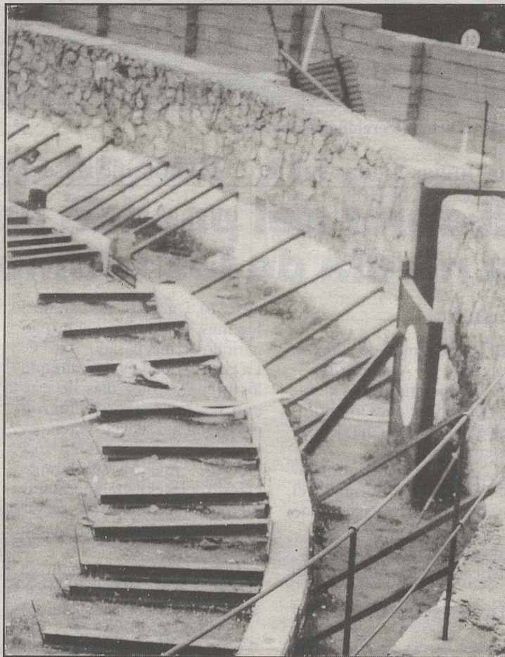
Obras en la plaza de toros de Navalperal.
