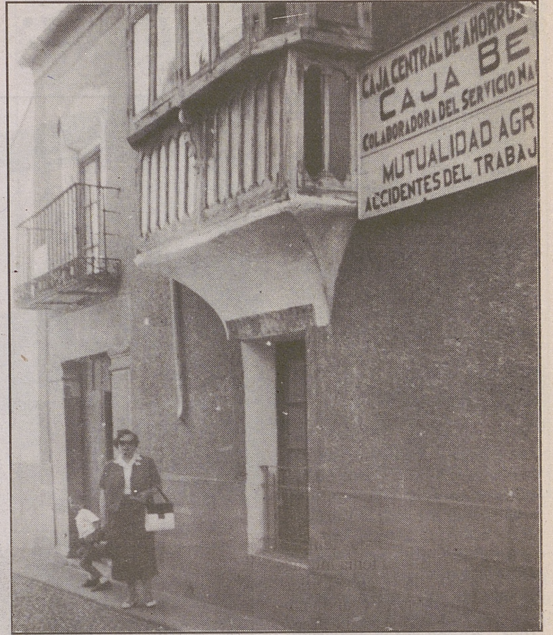
La casa de la carmelita antes de su demolición
